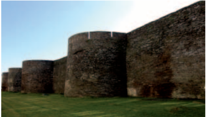
A muralla de Lugo data da época romana, comezando coa súa construción probablemente contra o ano 260, ao medrar a importancia de Lucus Augusti como centro de comunicacións e comercial do norte peninsular. A devandita construción delongouse ata a época de Constantino, rematando sobre o ano 325. Esta muralla da conta do esplendor da Galiza romana do século III e IV
