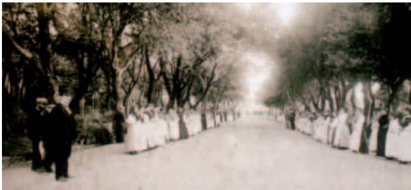
Entrada na fábrica de Fiados Barcón, Ferrol a finais do XIX. Empregadas formando en fila agardando ao patron
