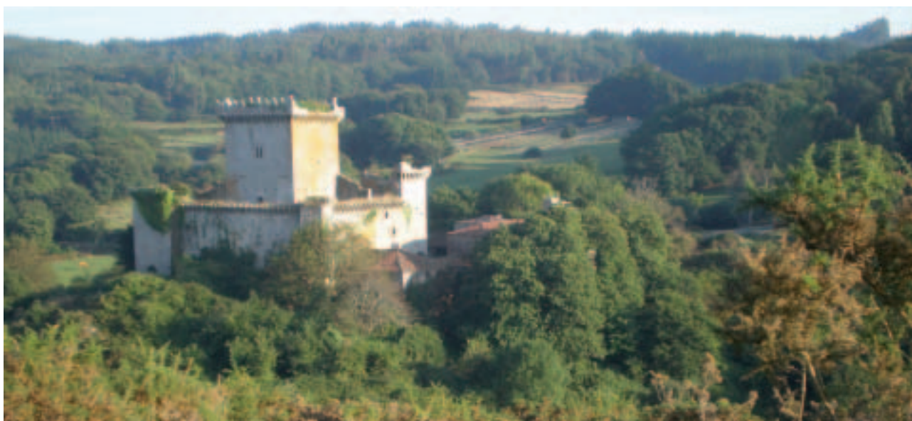
Castelo de Pambre (Palas de Rei); ollada panorámica dende O Castro do mesmo nome
